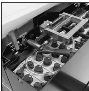
Batterie ad elevata capacità
